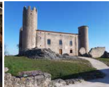
Mise en place du Centre d'Interprétation des gorges de la Loire au château d'Essalois - 2017 / 2021
